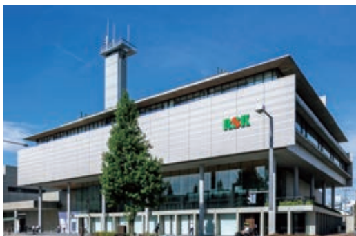
全景 / RSKイノベイティブ・メディアセンター
