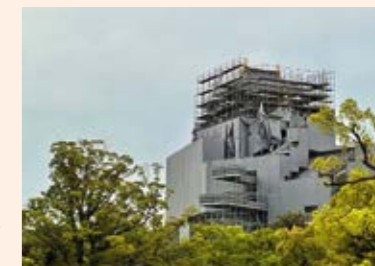
▲ 工事シートが外されていく岡山城天守閣
